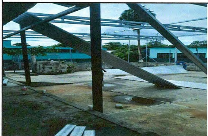
Foto 3: Renglón 1 techo de patio
