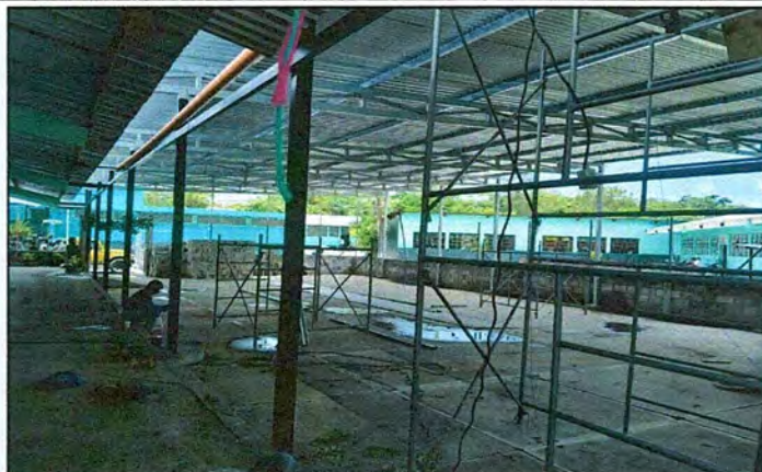
Foto 2: Renglón 1 techo de patio
