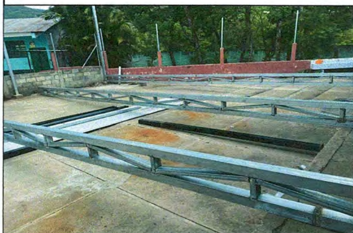
Foto 4: Renglón 2 muro perimetral
