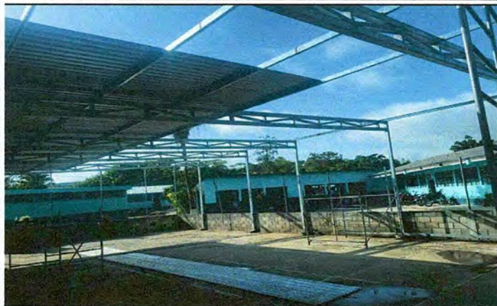
Foto 1: Renglón 1 techo de patio
